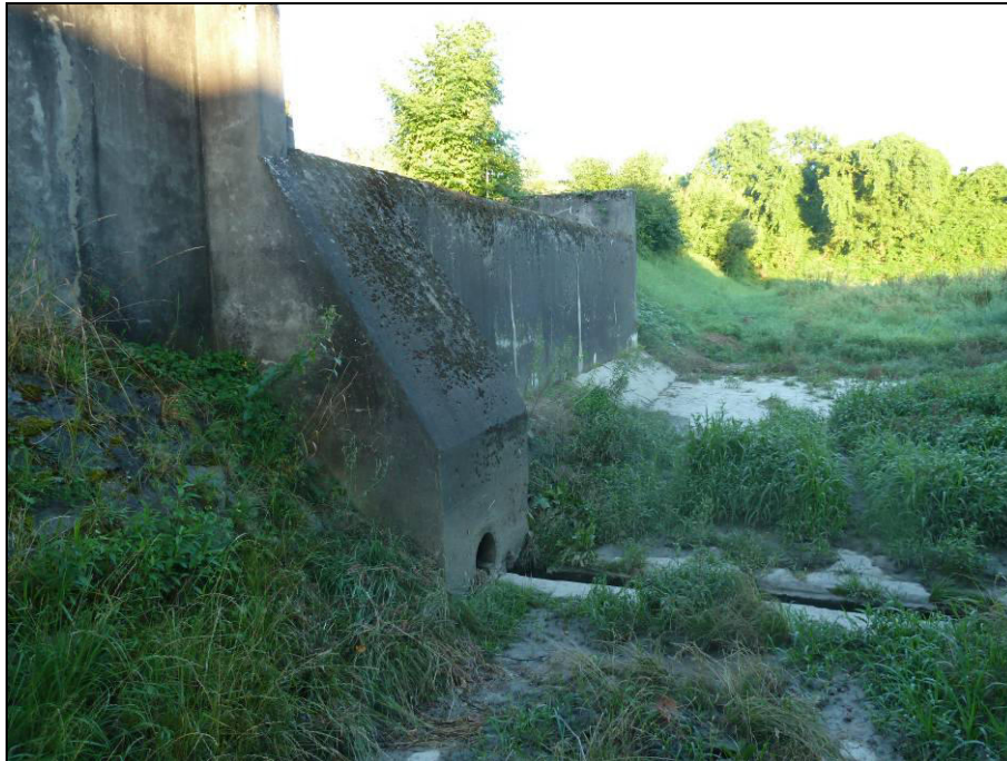
Foto 2: Staubauwerk mit vorgelagerter, versiegelter Fläche und Graben (Blickrichtung Süd-West, Foto vom 08.08.2016).
